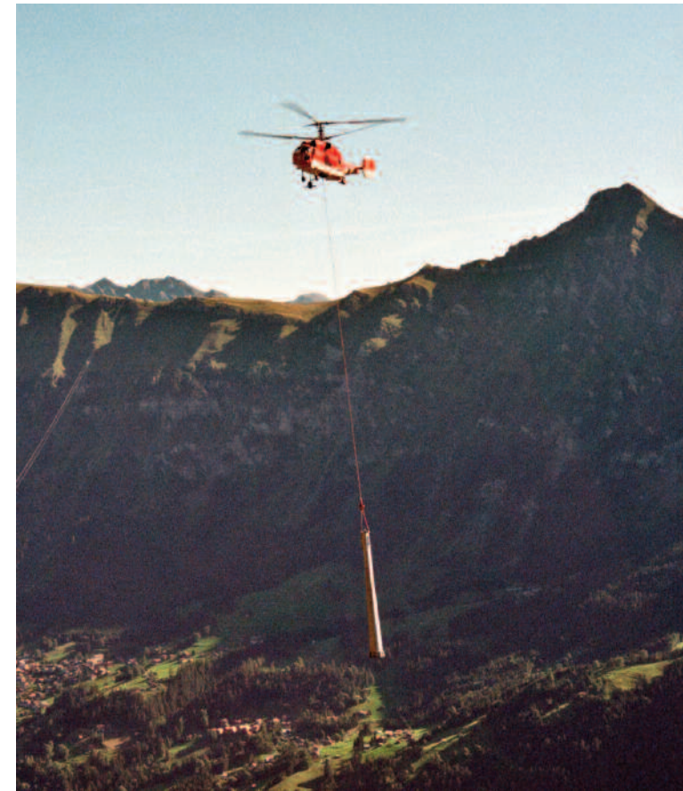
Helikopter Mastenmontage
